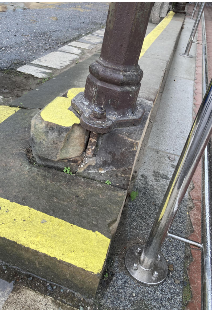
POŠKOZENÁ PATKA SLOUPU
