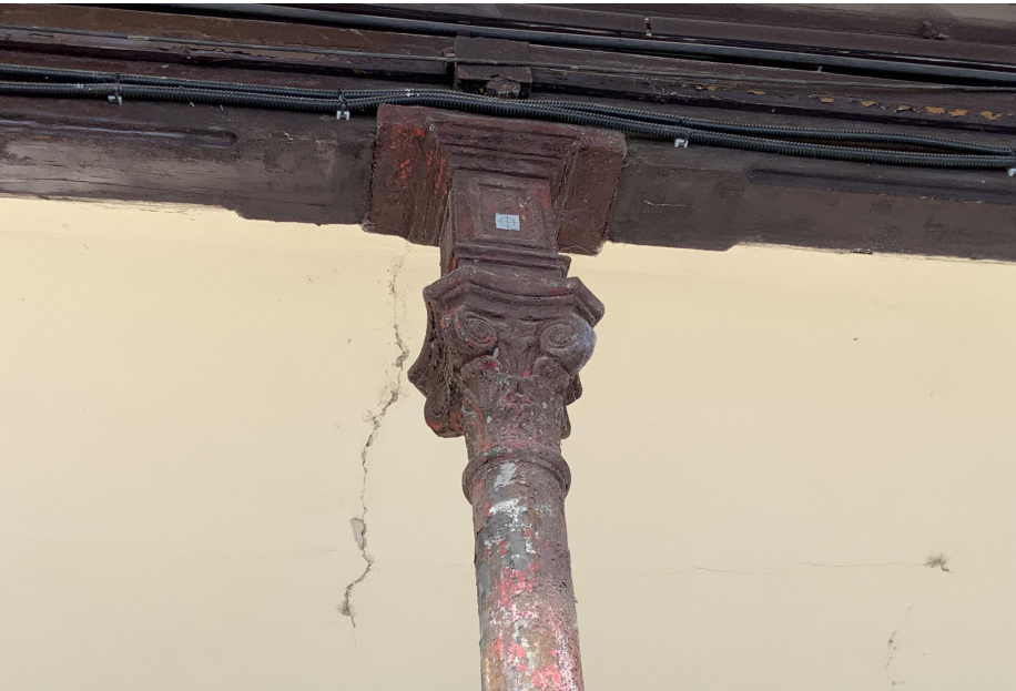
LITINOVÝ SLOUP ZAKONČENÝ KORINTSKOU HLAVICÍ S KRYCHLOVÝM NÁSTAVCEM
