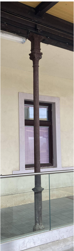
LITINOVÝ SLOUP ZAKONČENÝ KORINTSKOU HLAVICÍ S KRYCHLOVÝM NÁSTAVCEM
