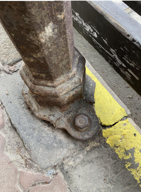
POŠKOZENÁ PATKA SLOUPU
